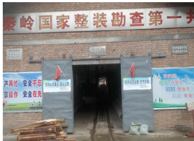
照片 1.3-3 898 竖井（镜向北）
