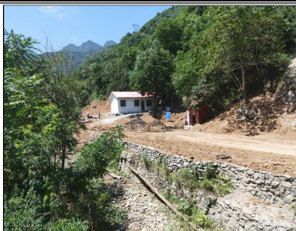
照片 2.6-6 工业场地建筑拆除 (镜向 250°)
