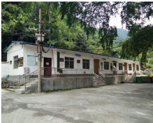
照片 1.2-8 变电室（镜向西北）
