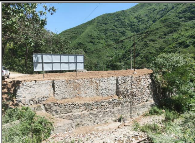
照片 2.6-5 设置拦渣挡墙 (镜向 45°)
