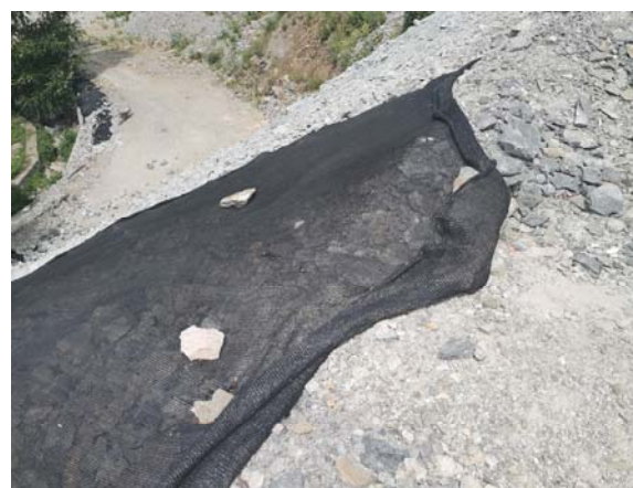
照片 2.6-4 Z2 废石周转场渣坡局部覆盖
