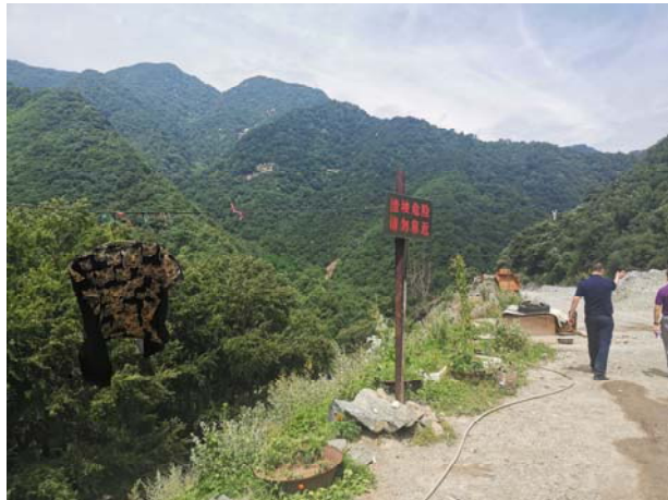
照片 2.6-2 Z2 废石周转场渣坡设立警示牌
