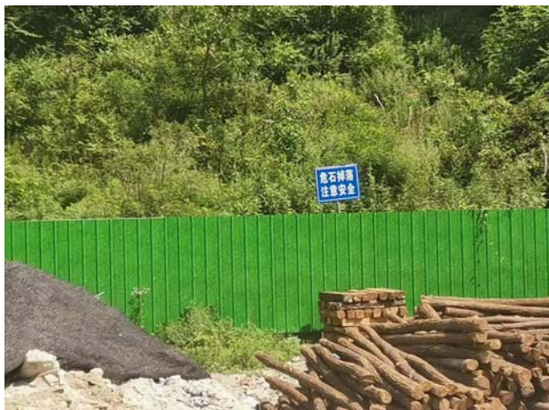
照片 2.6-1 BY1 崩塌隐患警示牌
