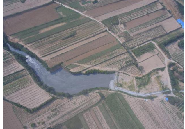
照片 1.3-12 马吉村尾矿库航拍照片
