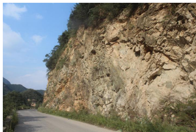
照片 3.2-6 B6 崩塌隐患点 (镜向 S)
