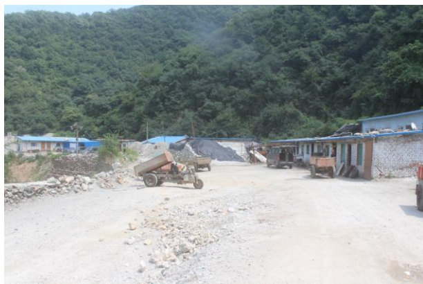
照片 1.3-9 PD68 临建场地 1 (镜像 E)
