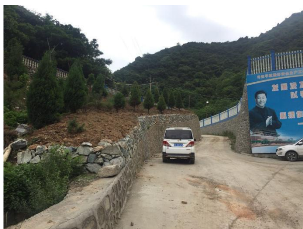
照片 2.6-6 工修建拦渣挡墙及绿化
