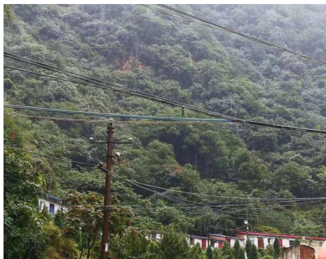
照片 3.2-2 B2 崩塌隐患点 (镜向 E)
