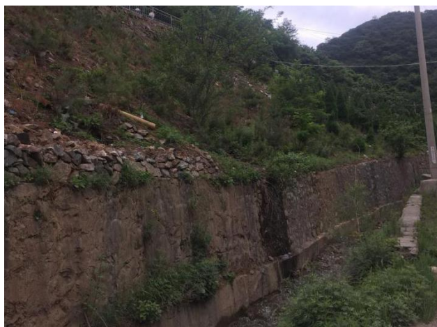
照片 2.6-3 拦渣工程
