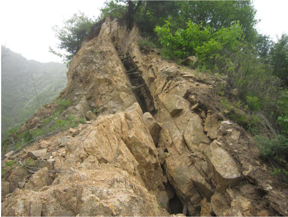
照片 3.2-6 坡体后缘裂缝
