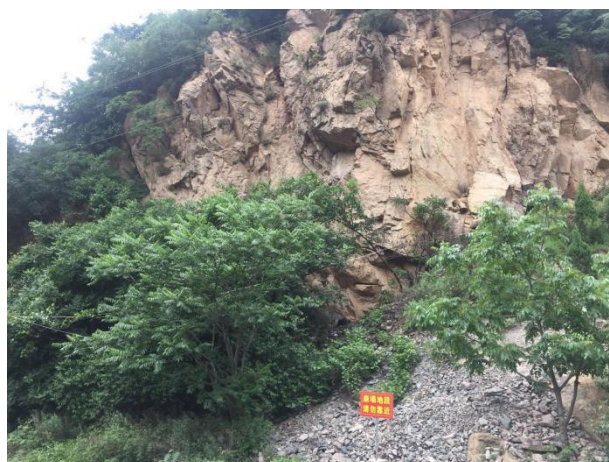
照片 2.6-2 B1 崩塌点警示牌
