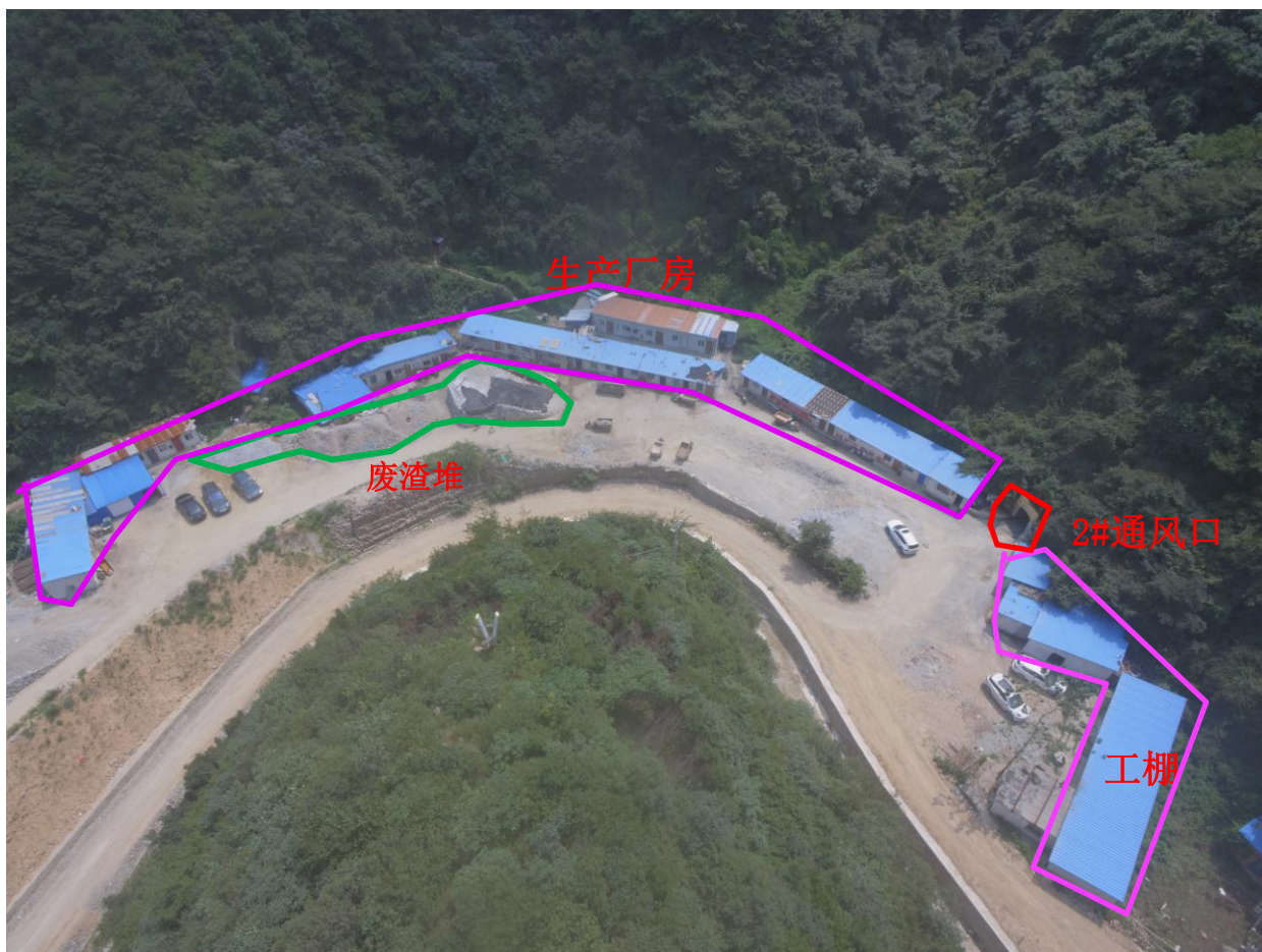
照片 1.3-8 PD69 临建场地全貌图 (镜像 WN)
