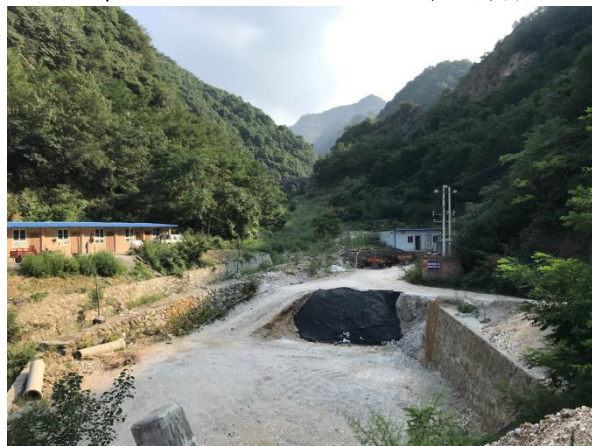
照片 3.3-3 KT6 临建场地压占（NE）
