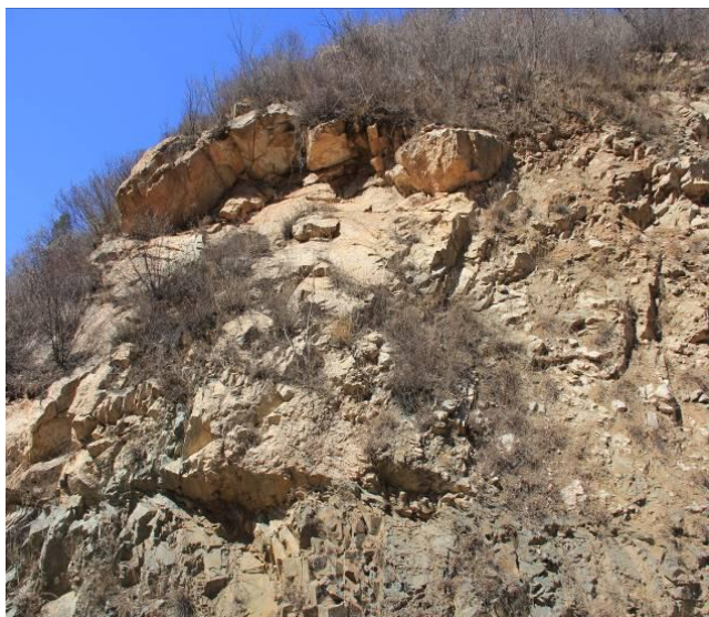
照片 3.2-3 B3 崩塌隐患点（镜向 E）
