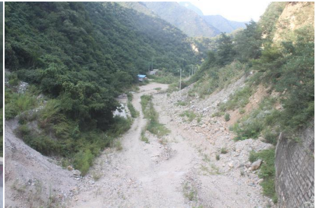
照片 2.5-4 沿沟道堆积的松散堆积物（镜向 N） （矿区潼峪段）
