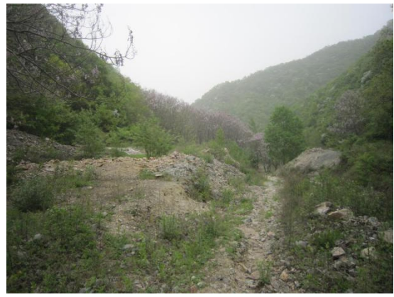
照片 2.5-2 蒿岔峪上游渣堆（镜向 ES） （蒿岔峪源头支沟，梁山沟）
