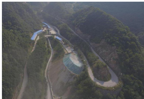
照片 2.5-6 公路边坡（镜向 S）
