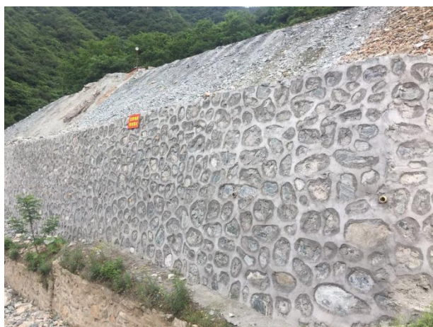
照片 2.6-1 拦渣工程
