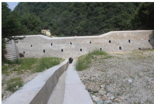
照片 2.6-15 拦渣坝工程
