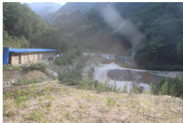
照片 1.3-10 KT6 临建场地 1(镜像 E)
