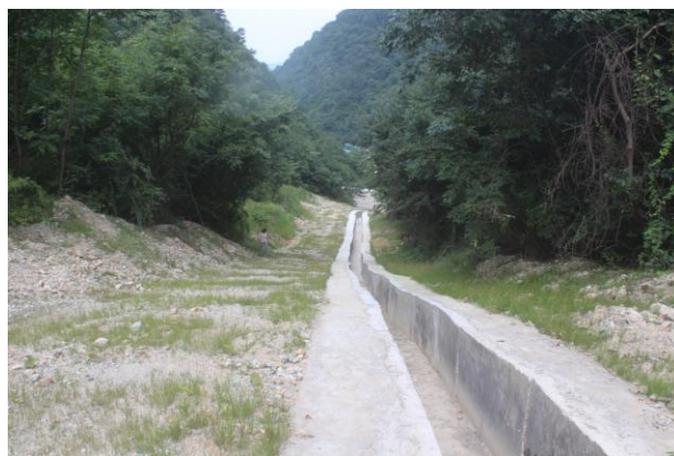
照片 2.6-16 排水渠工程
