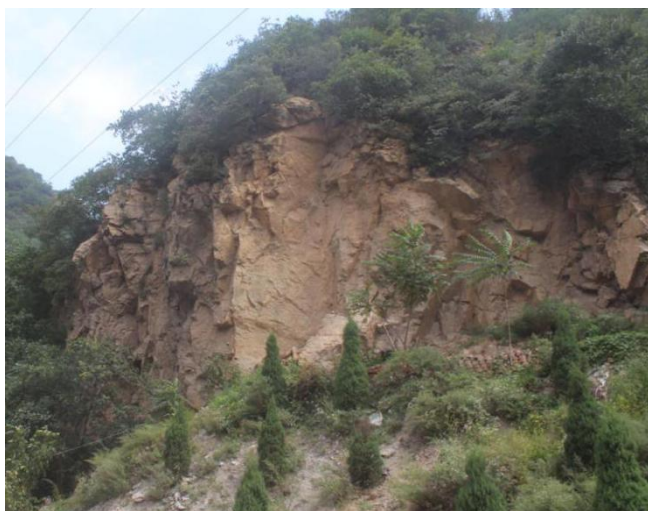
照片 3.2-1 B1 崩塌隐患点 (镜向 SE)
