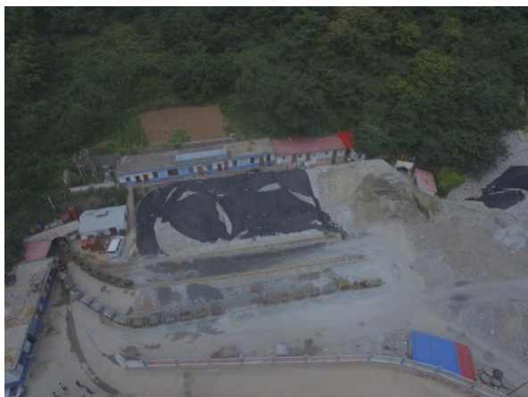
照片 3.3-1 PD68 工业场地压占（航拍）
