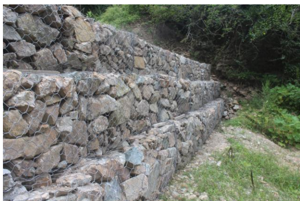
照片 2.6-15 石笼防护网挡墙
