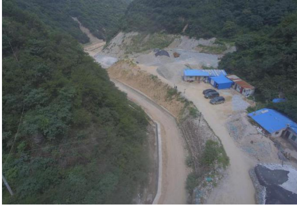
照片 2.5-1 蒿岔峪治理段（镜向 N） （蒿岔峪主沟道，PD69 场地附近）
