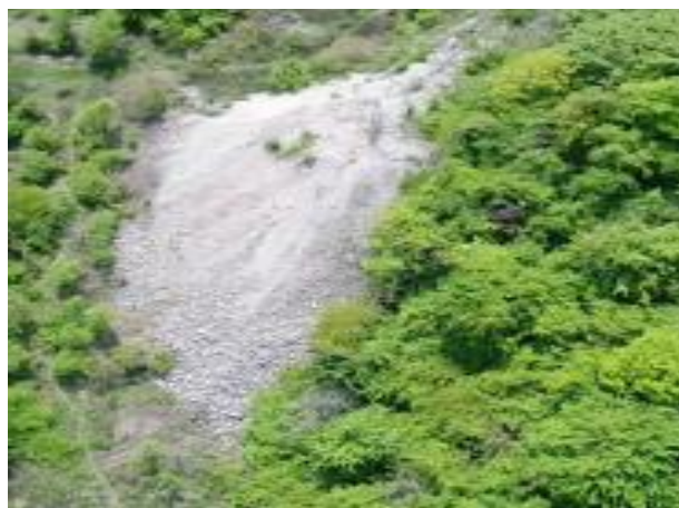
照片 1.3-18 ZD4 废渣堆（镜向 NW）
