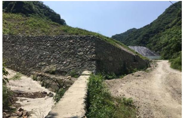
照片 2.6-2 现已修建挡墙及排洪渠+坡面复绿
