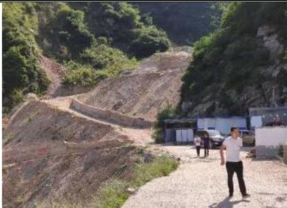
照片 2-7 Z1 渣堆挡墙 (1)
