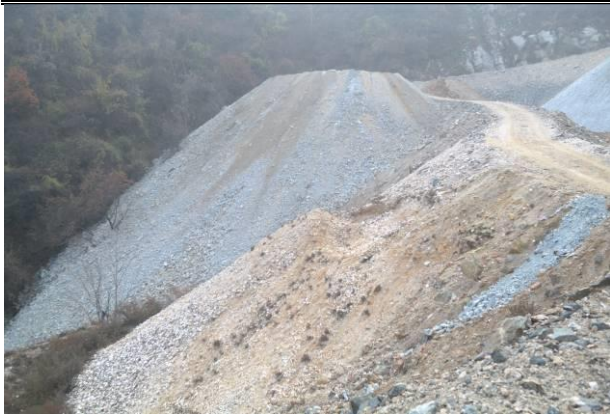
照片 3-4 第 1 阶边坡 镜向 S
