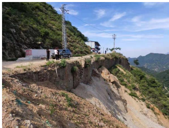
照片 2-6 工业场地边坡挡墙
