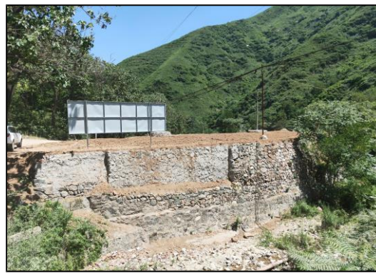
照 2-10 工业场地建筑拆除（镜向 250°）
