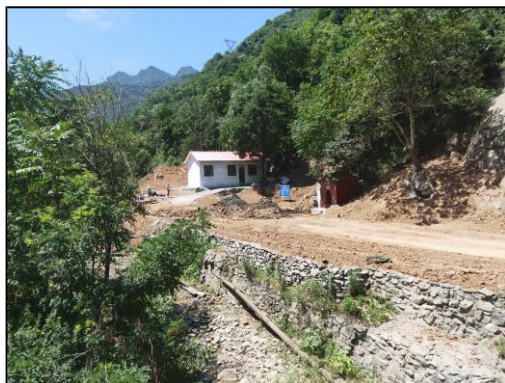
照片 2-9 设置拦渣挡墙（镜向 45°）
