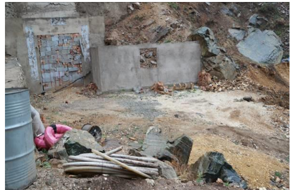
照片 1-2 一坑工业场地（镜向 10°）
