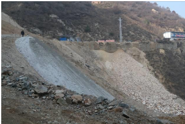
照片 3-6 第 2 阶边坡 镜向 N
