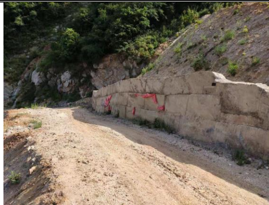
照片 2-8 Z1 渣堆挡墙 (2)
