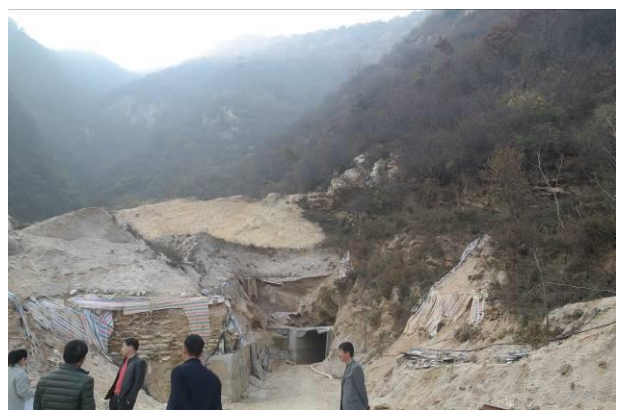
照片 1-6 风井坑口 镜向 282°
