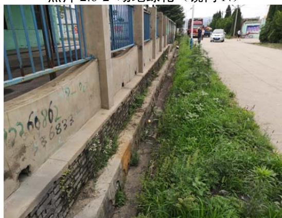
照片 2.6-4 场内排水沟 (镜向 S)
