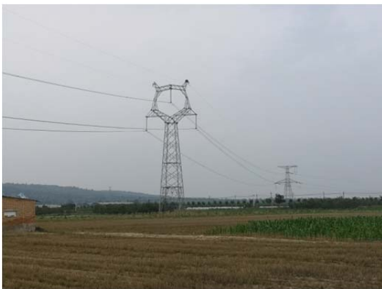
照片 2.5-3 高压线及塔基（镜向 NE）
