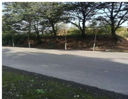
照片 3.2-2 TX2 地表牢固路现状（镜向 N）
