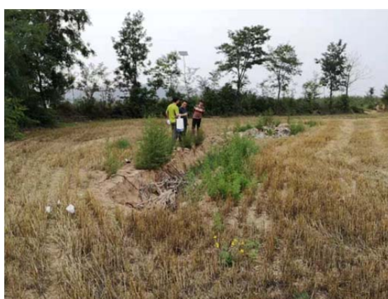
照片 3.2-4 TX4 地面裂缝（镜向 S）
