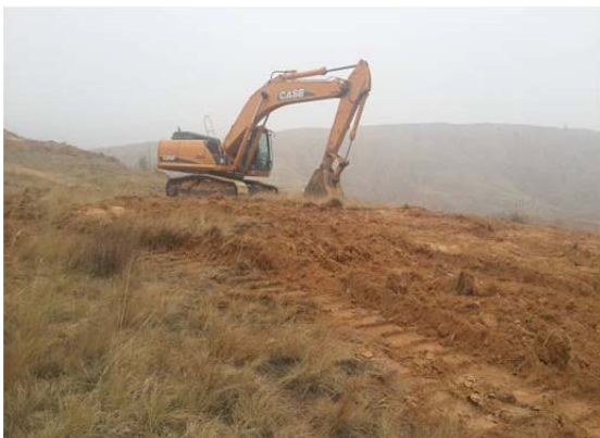
照片 2.6-7 裂缝填充（镜向 NW）
