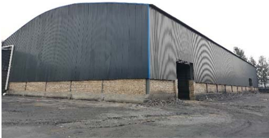
照片 1.3-3 储煤棚（镜向 NE）
