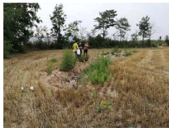
照片 3.3-4 TX4 地面裂缝（镜向 S）
