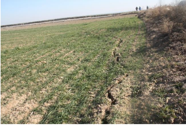
照片 2.6-3 董家河煤矿复垦前地表裂缝情况
