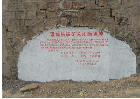
照片 1.4-2 已封闭的副斜井（镜向：W）
