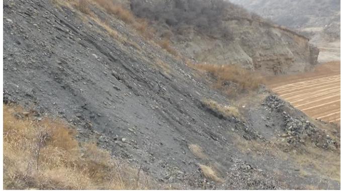
照片 3.2-2 原排矸场 1#滑坡细部 (H1)
