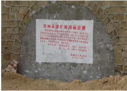
照片 1.4-1 已封闭的主斜井（镜向：E）
