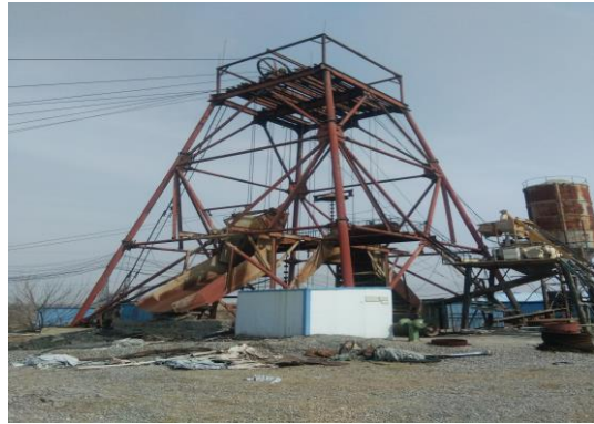
照片 1.3-2 主斜井（镜向：W）
