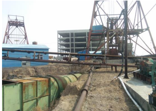
照片 1.3-4 建设中的工业场地（镜向：W）
