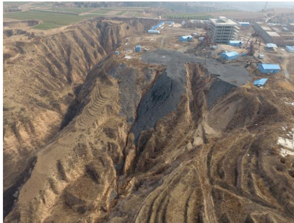
照片 3.2-4 排矸场（镜向：E）
