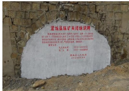
照片 2.6-2 原工业场地井筒封闭现状（镜像：NE）
