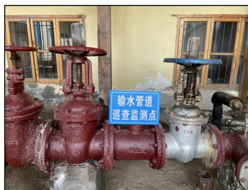
照片 1—6 输水管线工程
