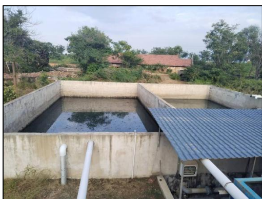
照片 1—5 污水沉淀调节池
